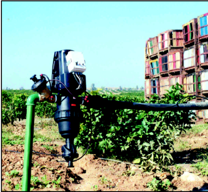
Filtration d'eau de réservoir pour irrigation au gouttes à gouttes.
